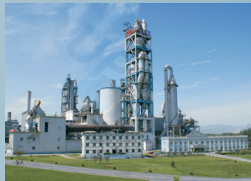
☐ 水泥业 Cement Plant
